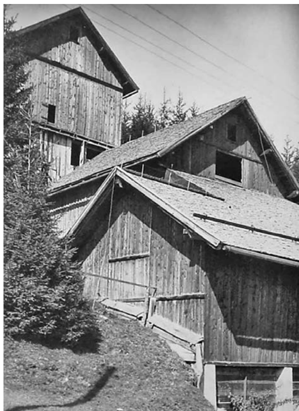
Abb. 3: Die „neue“ Betriebsanlage, die Holzgebäude sind nach Einstellung des Torfstiches in den 1960er Jahren abgebrannt.
