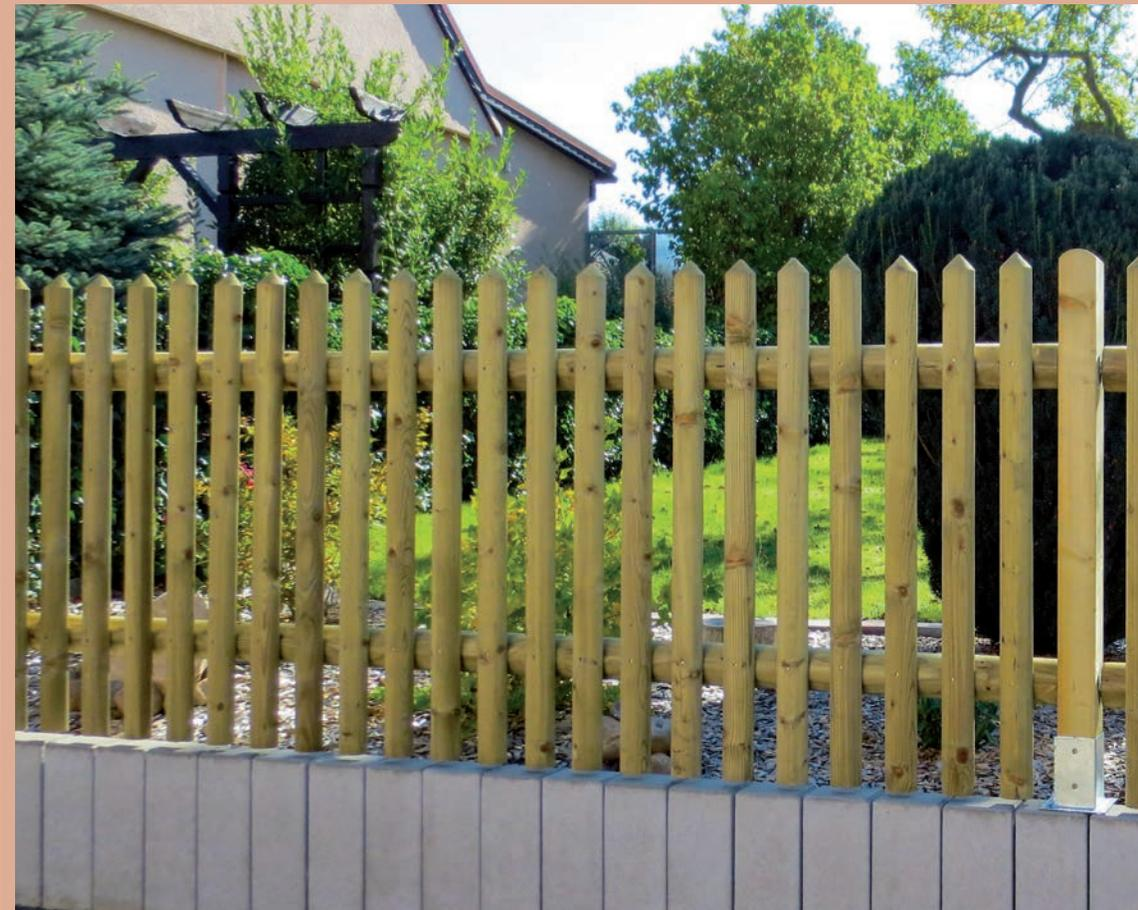
**Senkrechtzaun** halbrund gefräste **Latten 8,0 cm** breit, Spitzen kegelet, kesseldruckimprägniert
