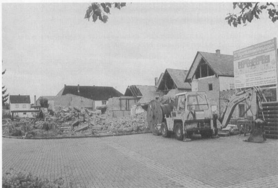
Abriß der Scheunenanlage in der Holzgasse 21 bis 25 im Juli 1992.
