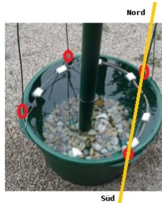
Unter das Rohr wird ein kleiner Stein gelegt, damit das Rohr vom Boden aus etwas Luft hat. Eine helfende Person hält das Rohr auf dem Stein möglichst mittig im Kübel und senkrecht.
