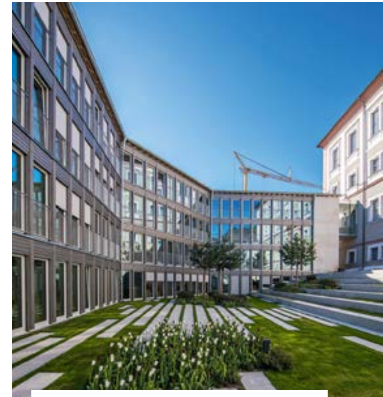
Bodentiefe Fenster bringen in alle Büroetagen Tageslicht. Von der Straßenseite aus betrachtet ist der Bau nur eingeschossig.
