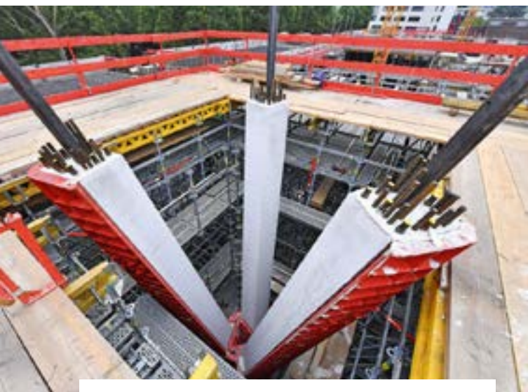
Für die Konstruktion der Baumstützen beim Neubau der Hauptverwaltung von HeidelbergCement kam eine eigens dafür angefertigte Spezialschalung aus Stahl zum Einsatz.
