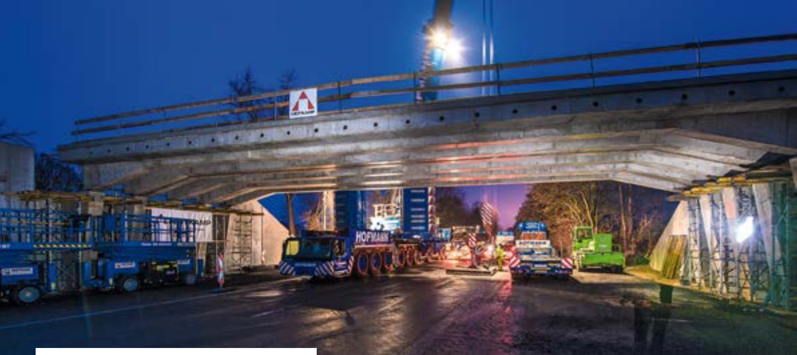
Schwerlastmodule transportierten die bis zu 110 Tonnen schweren Teile zum Einbauort, wo ein 750-Tonnen-Kran diese schließlich auf die Widerlager einhob.
