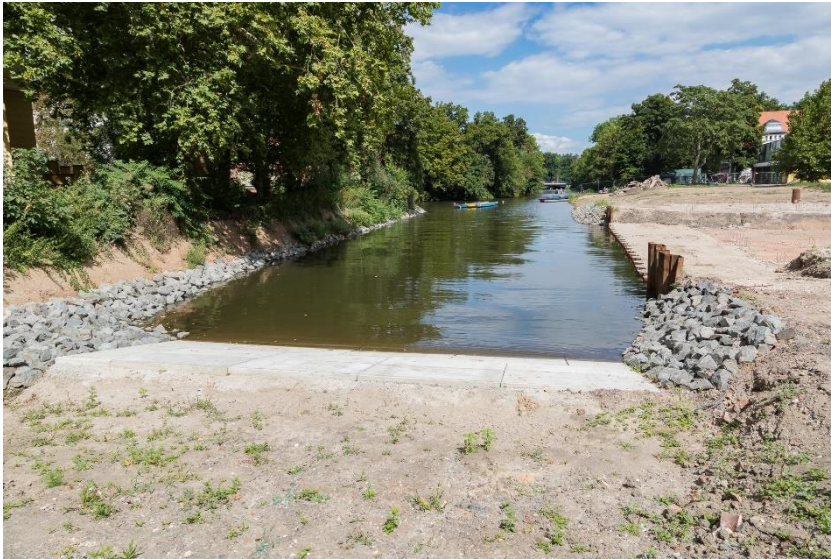
Foto 2: Gewässerausbau – Hafen -im August 2024 (s. Anlage)
