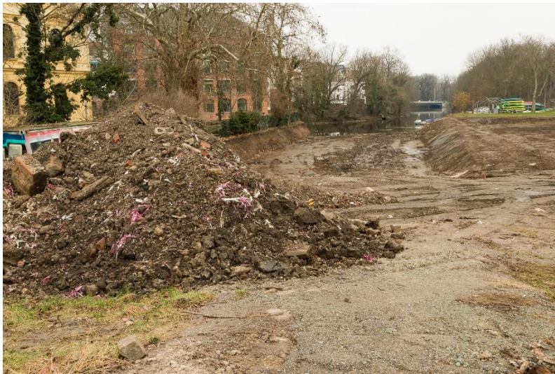
Foto 1: Gewässerausbau im Februar 2023 (s. Anlage)
