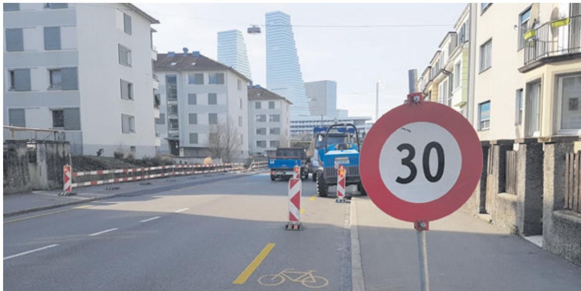
Im Abschnitt Magdenweglein bis Paracelsusstrasse wird seit Mitte Januar unter der Fahrbahn die Fernwärmeleitung verlegt. (Bild: Thomas Schneider)
