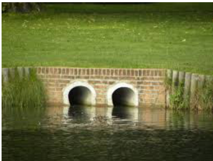
Voorbeeld bemetselde duiker met beperkte diameter van de doorstroom
