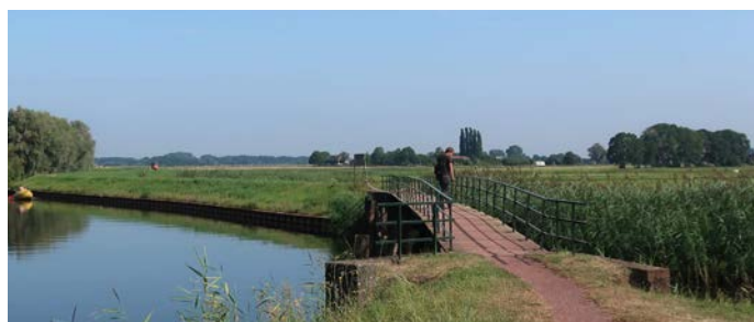
R3 - Voetgangersbrug langs het Apeldoorns Kanaal
