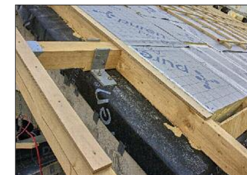
Als Dampfbremse verlegten die Dachhandwerker die hochreißfeste und gewebearmierte Schalungsbahn TOP DSB 100 auf der Holzschalung.
