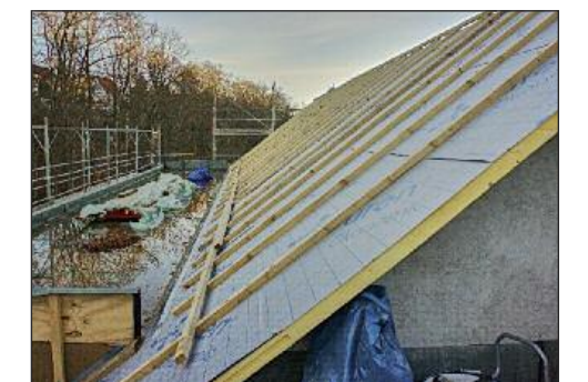
Die umlaufend mit Nut und Feder ausgestatteten Dämmplatten sind oberseitig mit der diffusionsoffenen Unterdachbahn Diffucell kaschiert.
