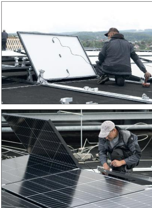
Die einzelnen Module der PV-Anlage wurden auf einem lose aufgelegten Schienensystem mit integrierter Schutzlage montiert.
