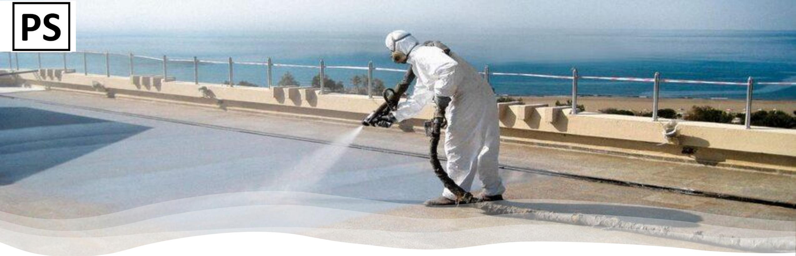
La poliurea es un producto usado para la impermeabilización y protección de superficies, que resiste el contacto permanente con agua sin que ello perjudique o afecte a sus propiedades impermeabilizantes, a su envejecimiento o durabilidad.
