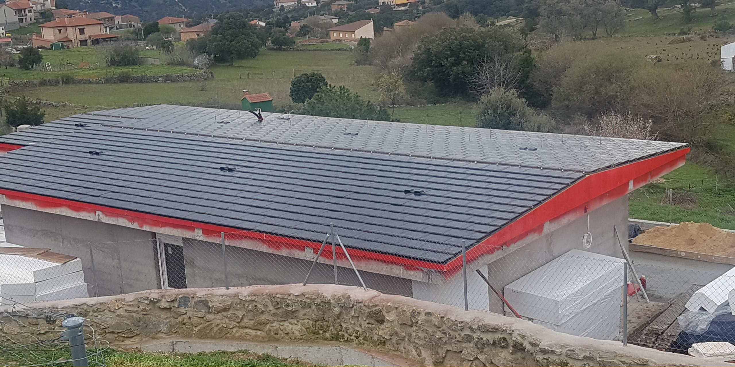
ASPECTO FINAL DE LA CUBIERTA CON SISTEMA CoverTherm-CLV
