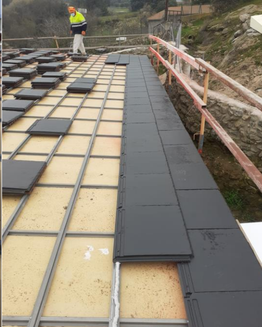
Colocación de tejas.
