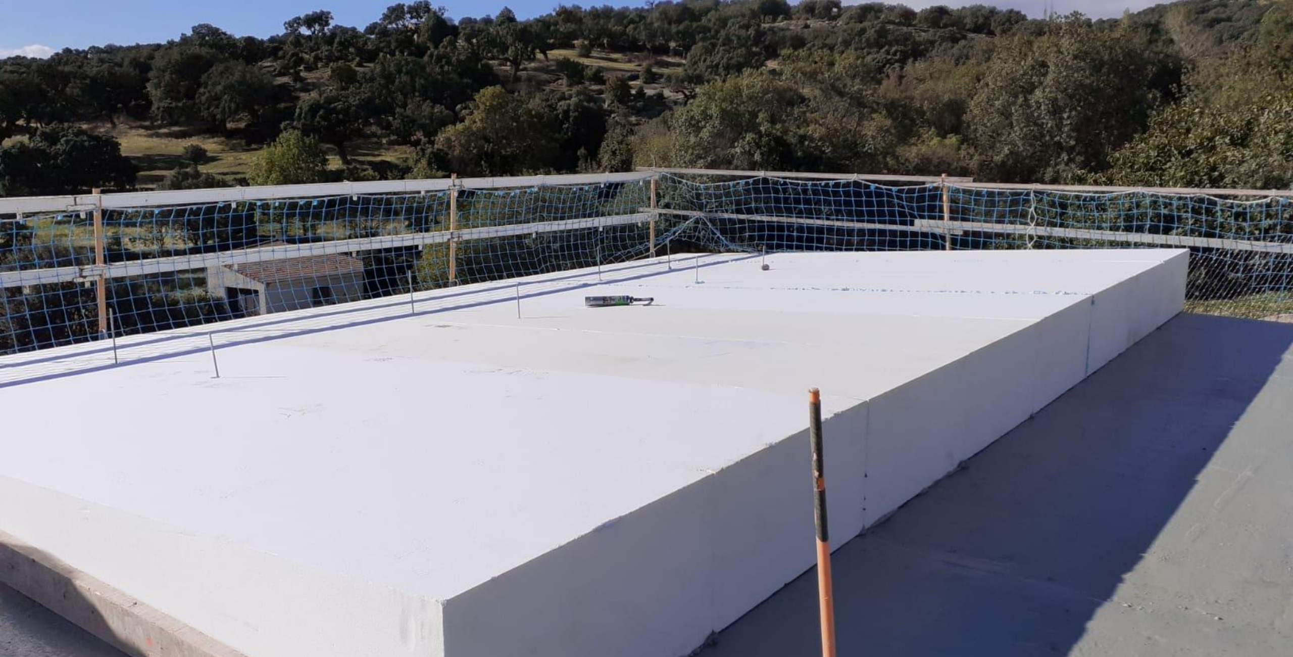
Posicionamiento de placas de Poliéstireno EPS
