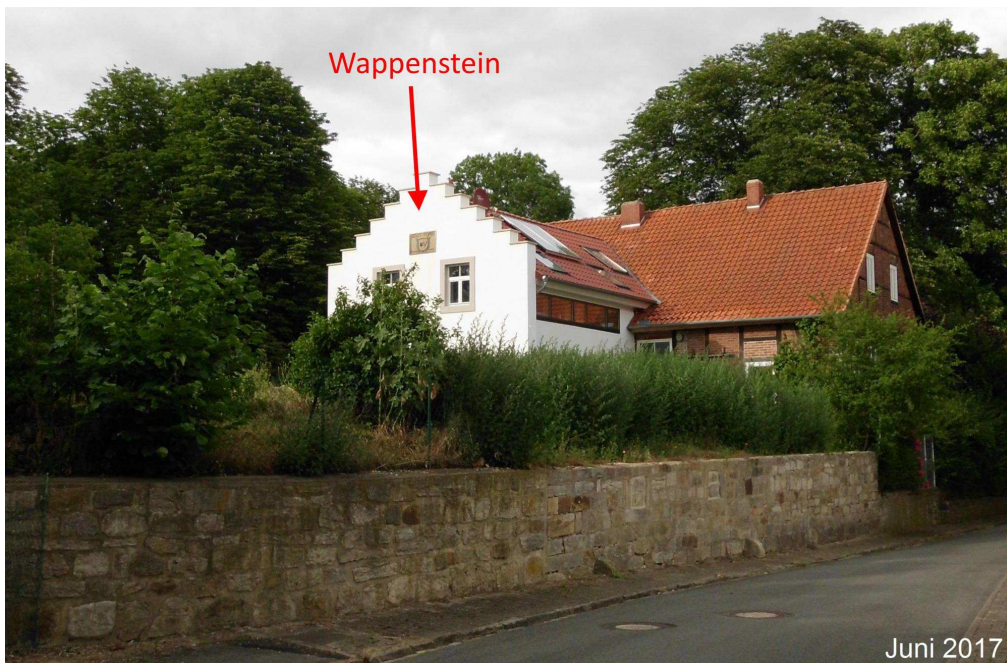
Ansicht von der Schafstraße. Der Wappenstein befindet sich nun im Giebel des Anbaus.
