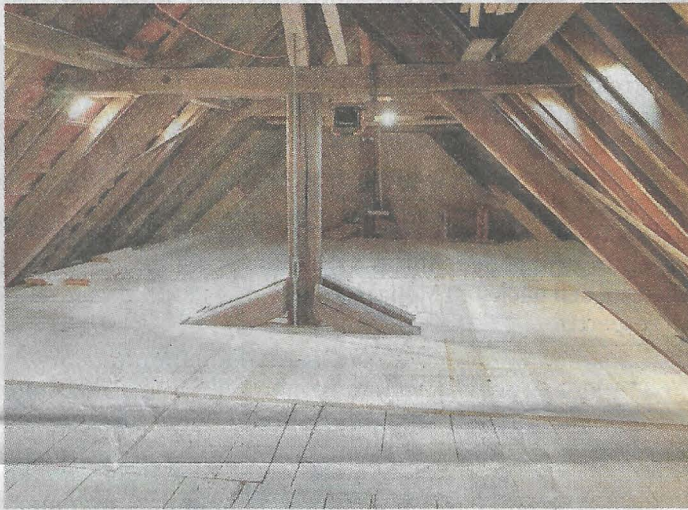
Neue Dielen werden auf den historischen Dielen der Kehlbalckenlage verlegt.
