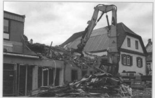
Abriss: Auf der Fläche des Zwischenbaus beim Altenzentrum ist schon mit dem Neubau begonnen worden. Foto: Klaus Eichenlaub
