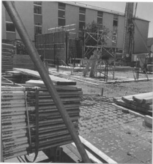
Blick auf die Baustelle Anfang des Jahres 2020, Foto: Rieder, privat
