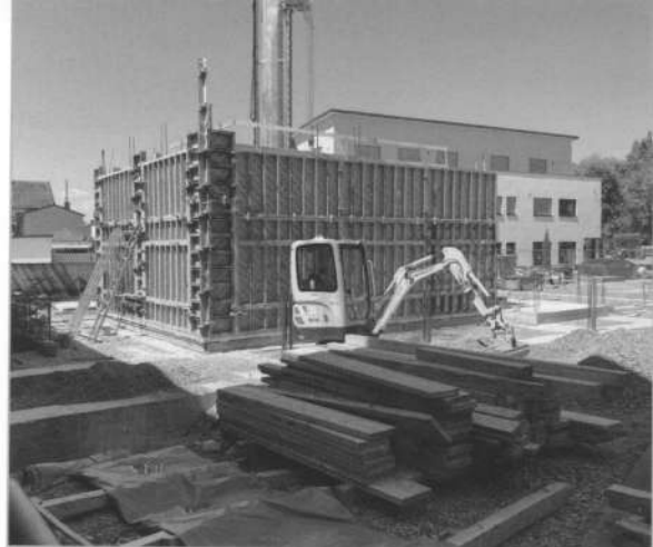
Baustelle Grundschule, Mai 2020
