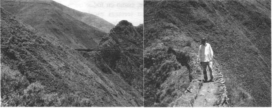
Figura 5. Canal, visto desde el camino y desde el mismo canal.
