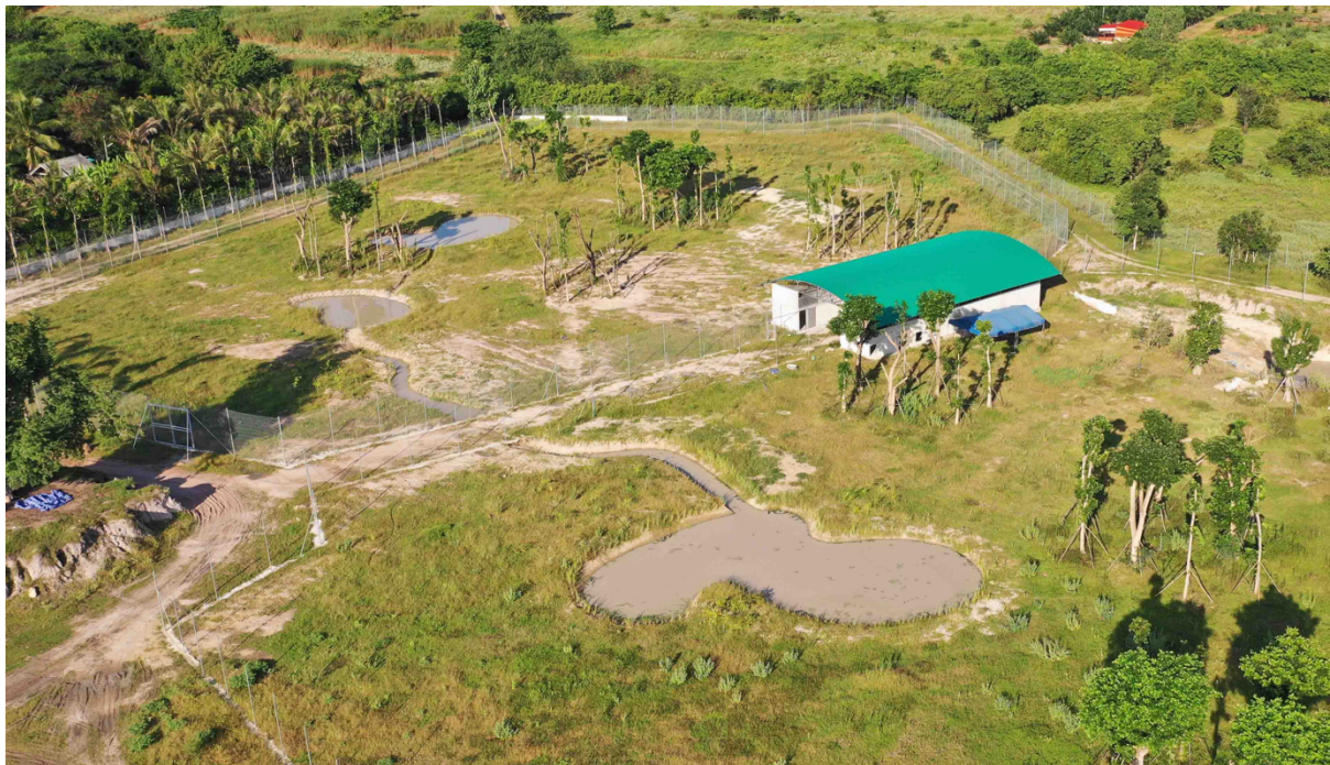
Bouw tijger opvang Thailand 2019
