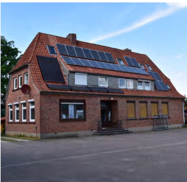
Abb. 55 Solaranlagen in Toppenstedt
