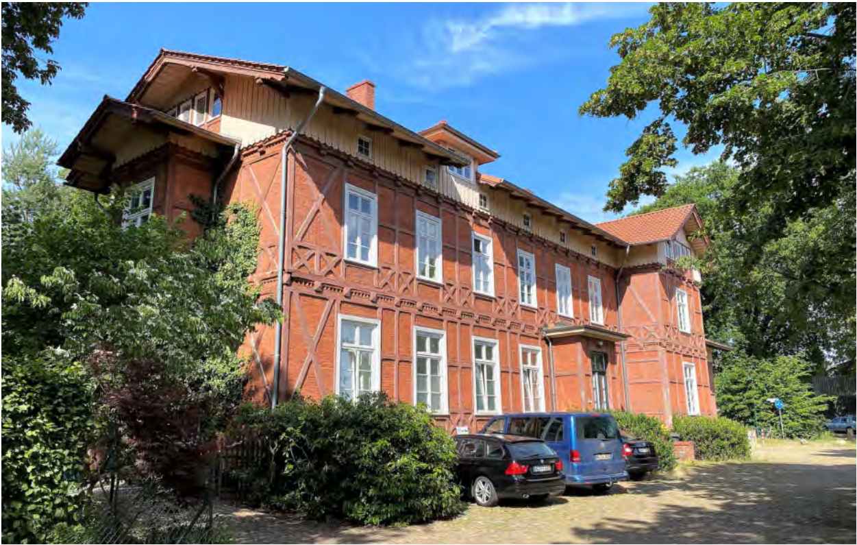
Abb. 126 Wohnen im ehemaligen Bahnhofsgelände
