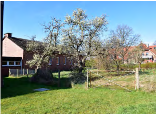
Abb. 124 Revitalisierung Gemeindehaus Toppenstedt
