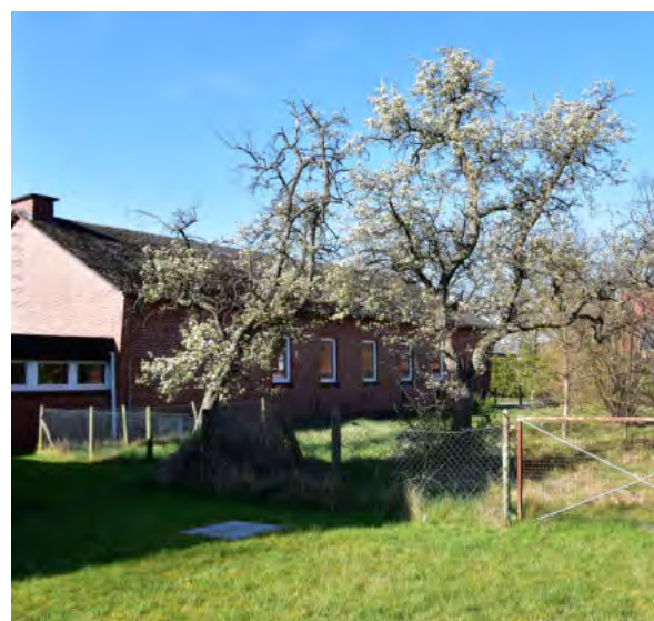
Abb. 40 Revitalisierung Gemeindehaus Toppenstedt
