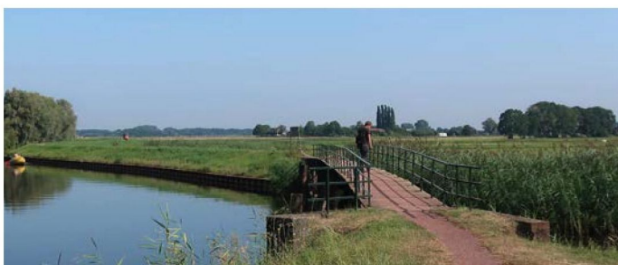
R3 - Voetgangersbrug langs het Apeldoorns Kanaal
