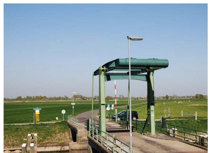
De Hoenwaardsebrug heeft kenmerkende groene kleuren op de hefconstructie en relingen
