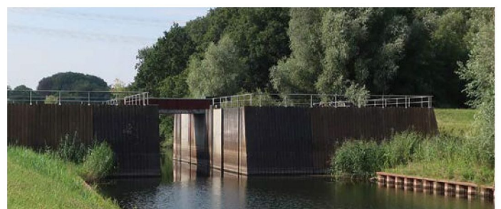
Het Bastion over het Apeldoorns Kanaal (bij R3)
