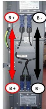
Jedes Gerät an die Erdungsanlage anschließen.
