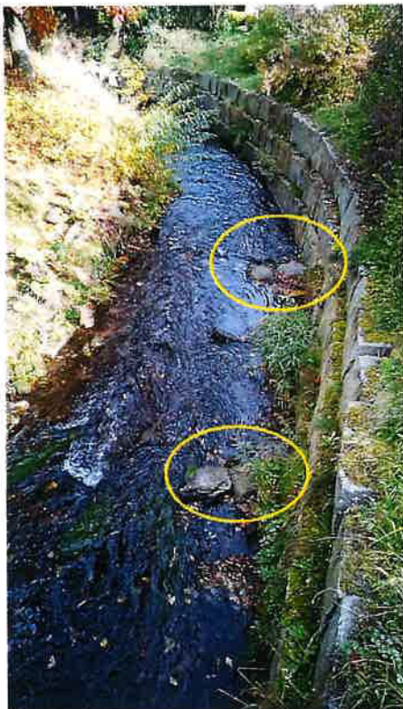
Lenkbuhnen farblich markiert
