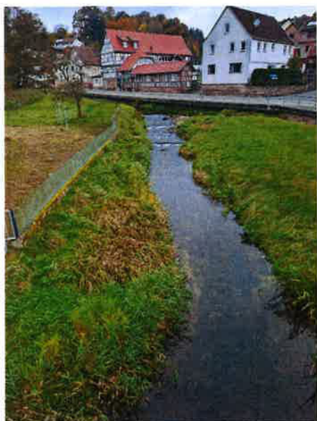
Anlandung im Oberstrom der Bogenbrücke
