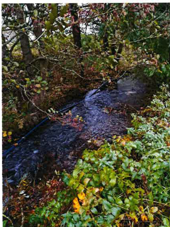
Blick auf freigespülte Wasserleitung
