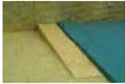
Druckfeste Gefälledämmplatte für die Wärmedämmung im Flachdach
