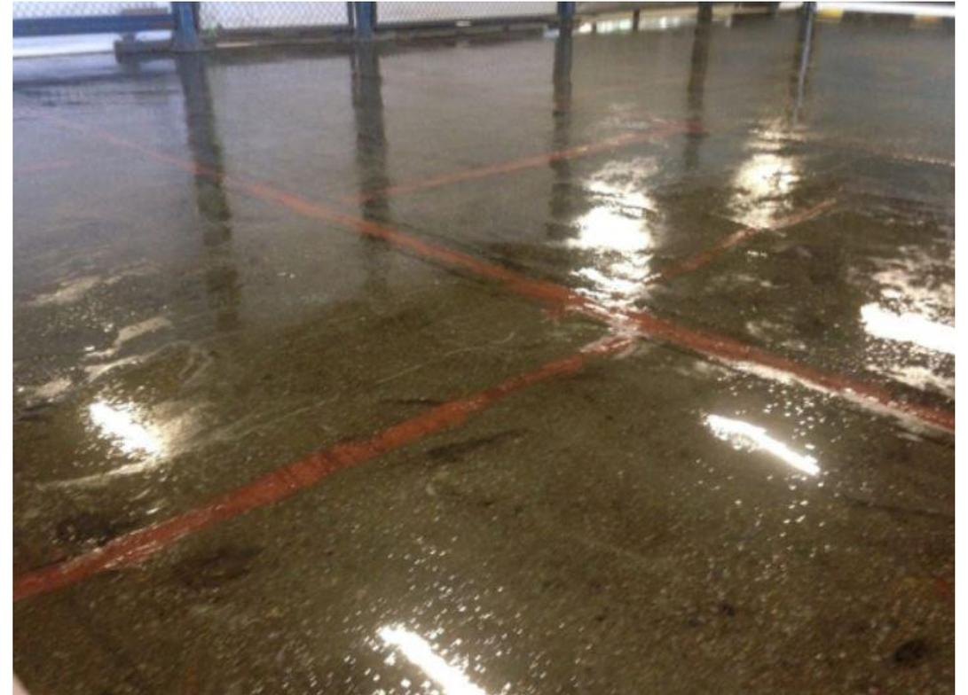
Aplicación a rodillo de una segunda (2ª) mano de pintura epoxi 100% sólidos **Pavifer-311** en la totalidad de la superficie a tratar. 150 gr/m<sup>2</sup>
