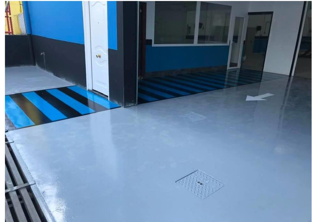
Aplicación a rodillo de una segunda (3ª) mano cruzada a la anterior de pintura epoxi 100% sólidos **Pavifer-311** en la totalidad de la superficie a tratar. 150 gr/m<sup>2</sup> y marcación de señalización vial con pintura monocomponente para tráfico rodado.
