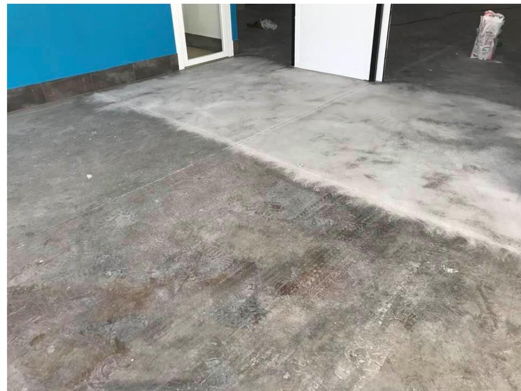
Sellado y relleno de fisuras, coqueras de toda la superficie con la aplicación de una resina epoxi 100% sólidos **Pavifer-303** + adición de tixotropante **Aerosil-200** a la resina.
