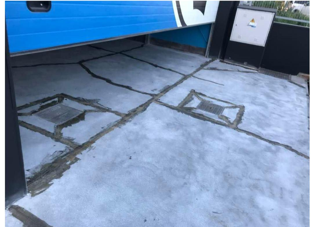
Aplicación a rodillo de una primera (1ª) mano de resina imprimante epoxi 100% sólidos **Pavifer-303** en la totalidad de la superficie a tratar. 200 gr/m<sup>2</sup>
