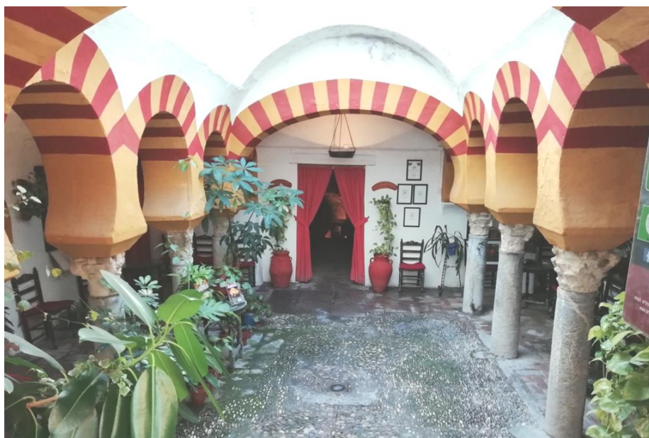
Fig. 4. Estado actual de la sala templada, convertida en patio (Foto: B. Vázquez)
