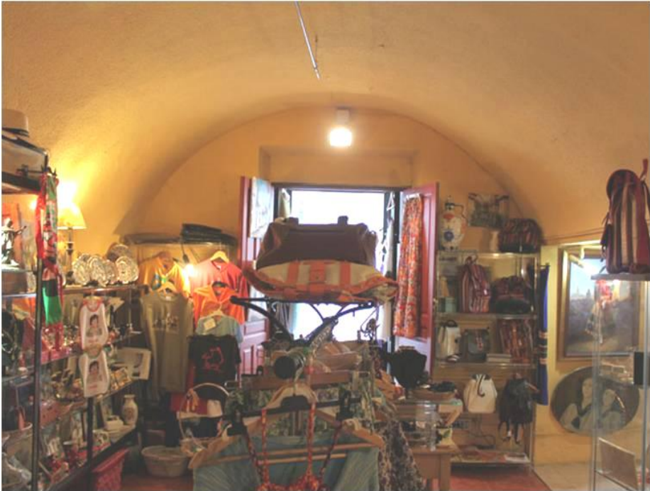
Fig. 3. Cubierta de bóveda de cañón de la sala fría (Foto: J. M. Tamajón)
