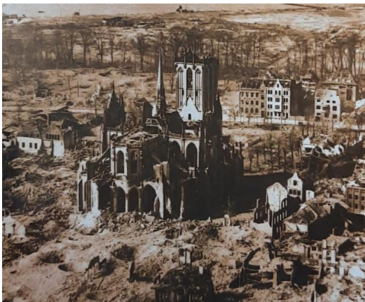
Blick auf das zerstörte Wesel mit Willibrordi-Dom und Großem Markt
