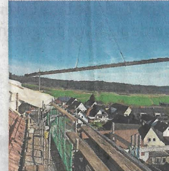
Der Kran bringt Material auf das Dach.
