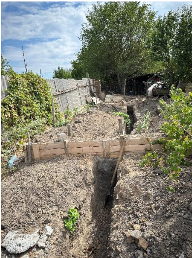
Fundament für den Sanitärtrakt
