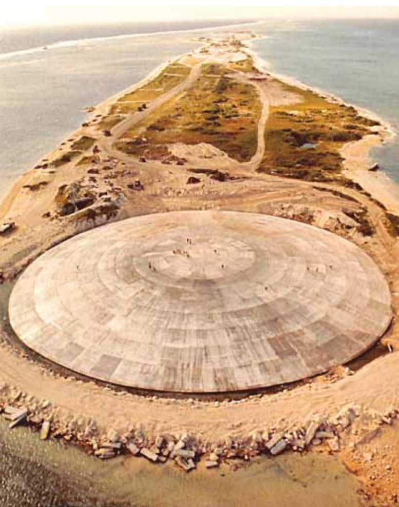
Der Deckel des Atommüllbunkers auf der Insel Runit im Pazifik hat seit mehreren Jahren Risse (US Defense Special Weapons Agency, Wikipedia).
