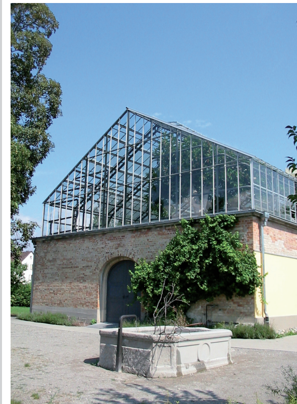
Palmenhaus nach der Instandsetzung, um 2006
