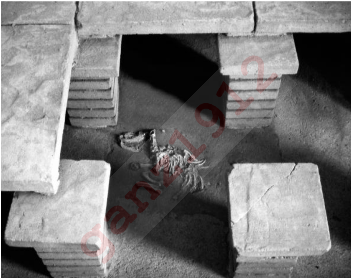
Figura 4.16 Parte de un hipocausto romano (con el esqueleto de un perro muerto por los gases) expuesto en el Museo Romano de Homburg-Schwarzenacker, en Saarland. Fotografía: Barbara F. McManus.
