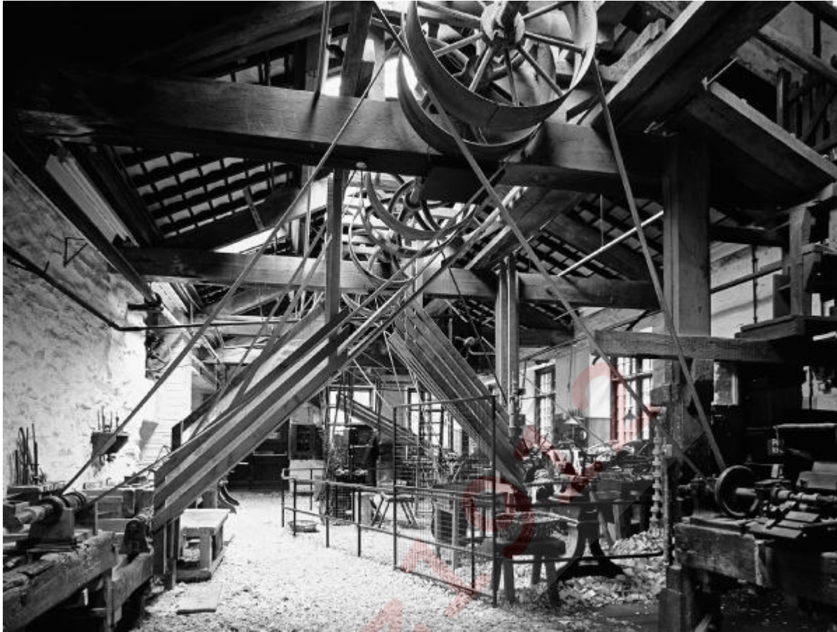
Figura 6.8 Interior del taller de torneado principal del molino de bobinas de Stott Park en Finthwaite, Lakeside, Cumbria, que muestra la típica disposición de correas aéreas transmitiendo la potencia de una gran máquina de vapor a máquinas de uso individual. La fábrica producía bobinas de madera para la industria del hilado y el tejido de Lancashire (Corbis).
