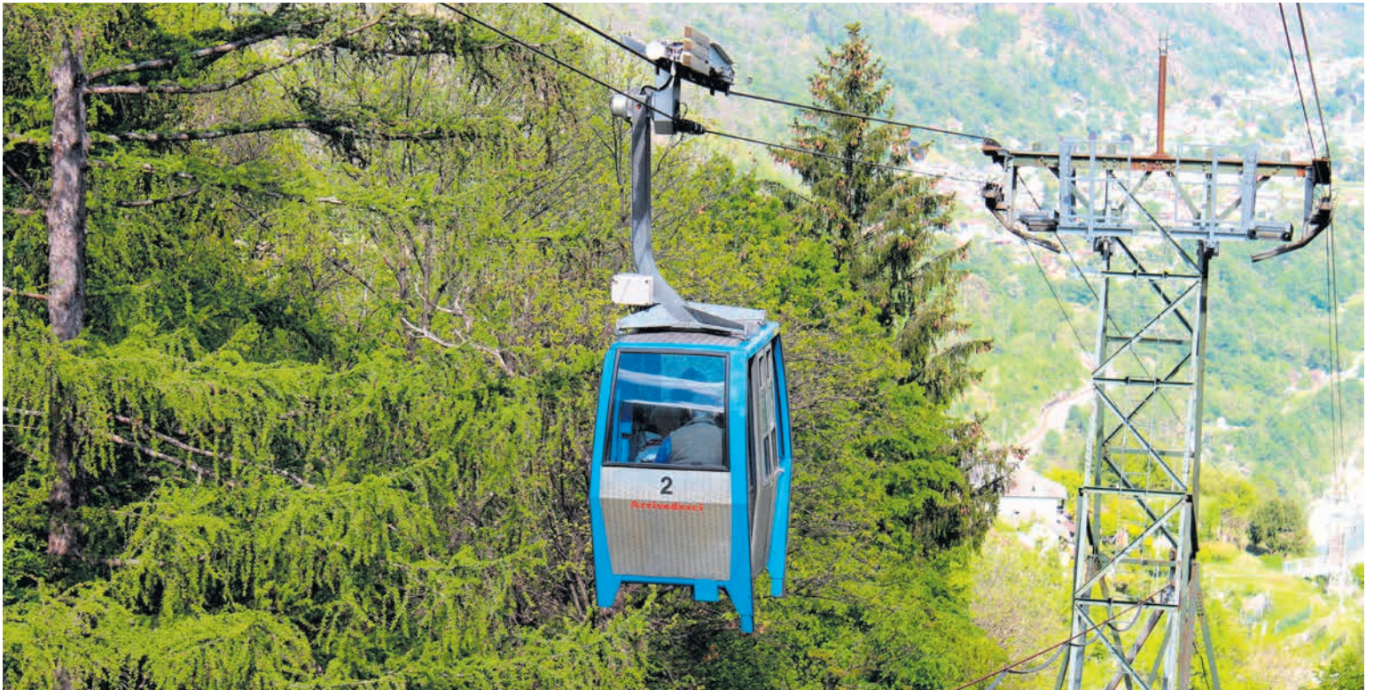
Die wahrscheinlich älteste Seilbahn im Tessin. Intragna-Pila-Costa, die unterdessen den Betrieb einstellen musste. (Bild: Armin Faes)
