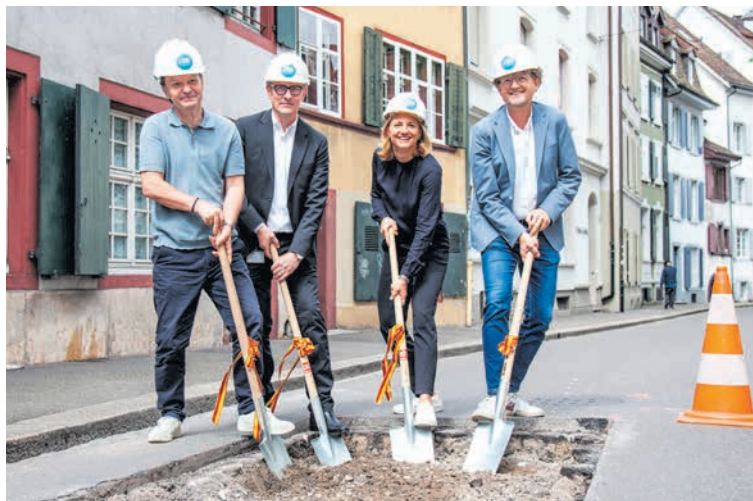
Spatenstich mit Baudirektorin Esther Keller. (Bild: BVD Basel-Stadt)
