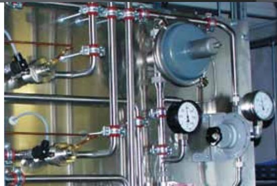
Vollautomatische Druckreglerstation für stationären Ansatz
