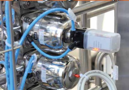
Ventilinseln in Bustechnologie zur Steuerung von Membranventilen. Der dezentrale Aufbau garantiert ein effizientes Anlagendesign.
