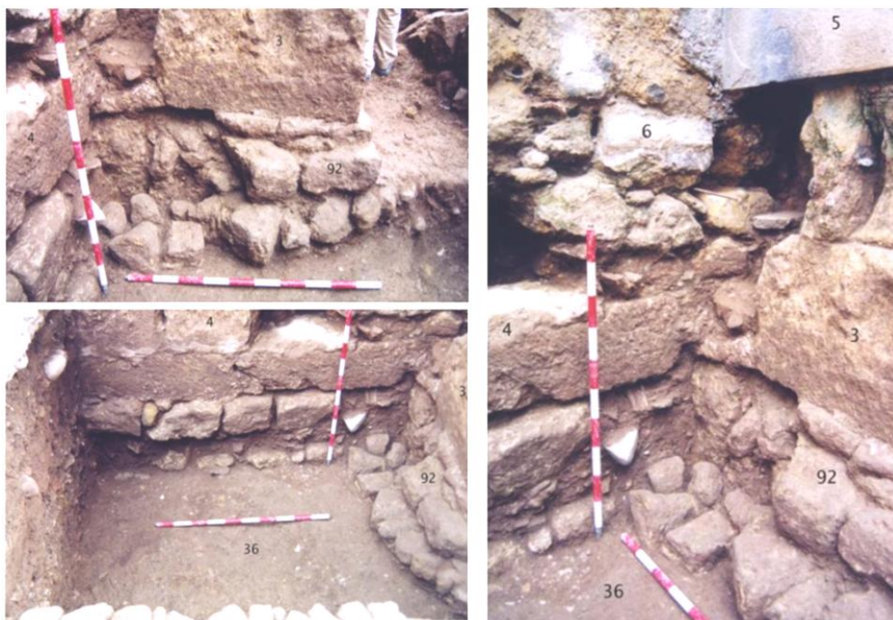
Fig. 14. Corte 7. Reparación del pilar
