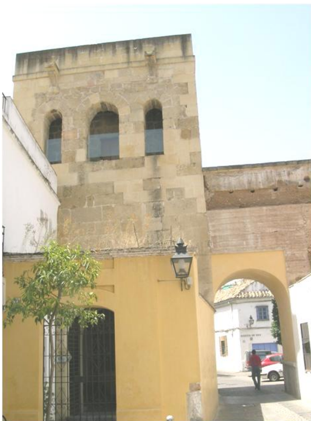
Fig. 8. Torre de Belén, que formaba parte del recinto amurallado del Castillo de la Judería
