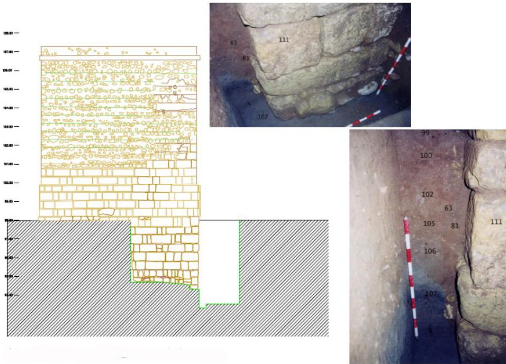
Fig. 13. Corte 8. Cimentación de la torre
