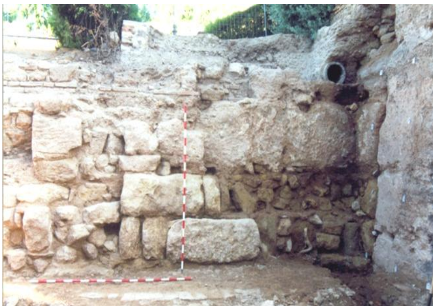
Fig. 8. Corte 19, aparejo a soga y doble tizón característico de época califal. ET. Murallas de Córdoba III (GMU)
