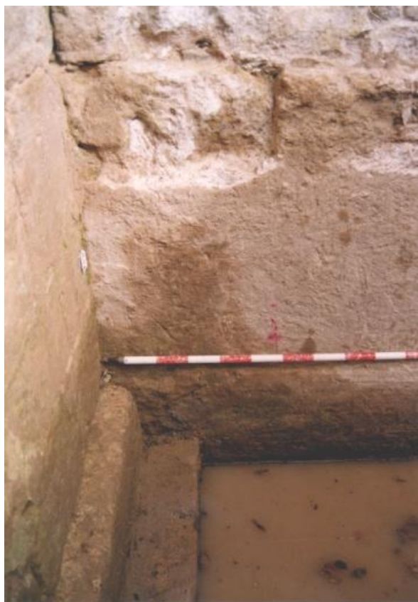
Fig. 10. Corte 4, se observa la cimentación de la muralla formada por un zampeado de sillarejos unidos con mortero de cal. E.T. Murallas de Córdoba II (GMU)
