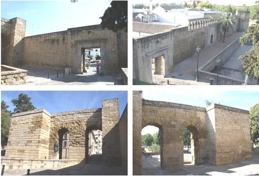
Fig. 2. Puerta de Sevilla y torre albarrana
