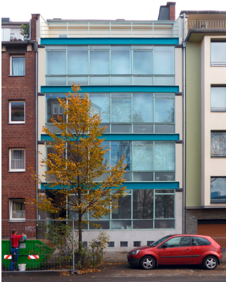
12. Metallfensteranlagen. Foto: Matthias Berg, Stadt Düsseldorf.
