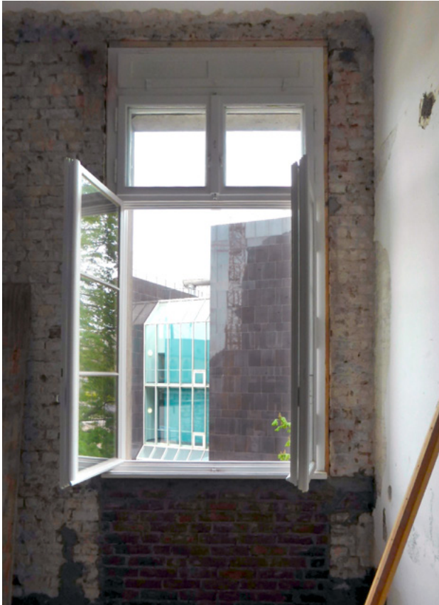
13. Historisches Verbundfenster. Foto: Matthias Berg, Stadt Düsseldorf.
