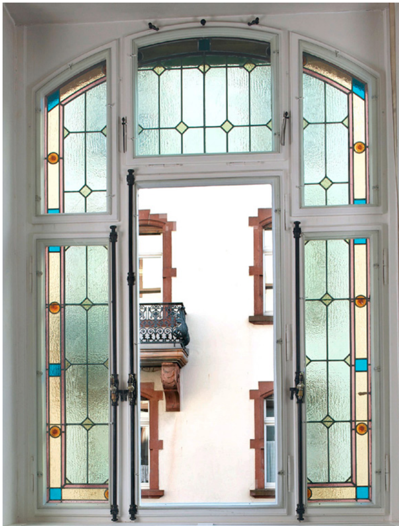
2. Ansicht von montierten Energiespar-Vorsatzscheiben. Foto: Guido Kramp.
