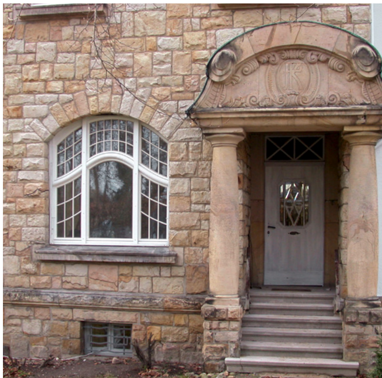
8. Rekonstruiertes Fenster + Restaurierung Hauseingangstür. Foto: Guido Kramp.
