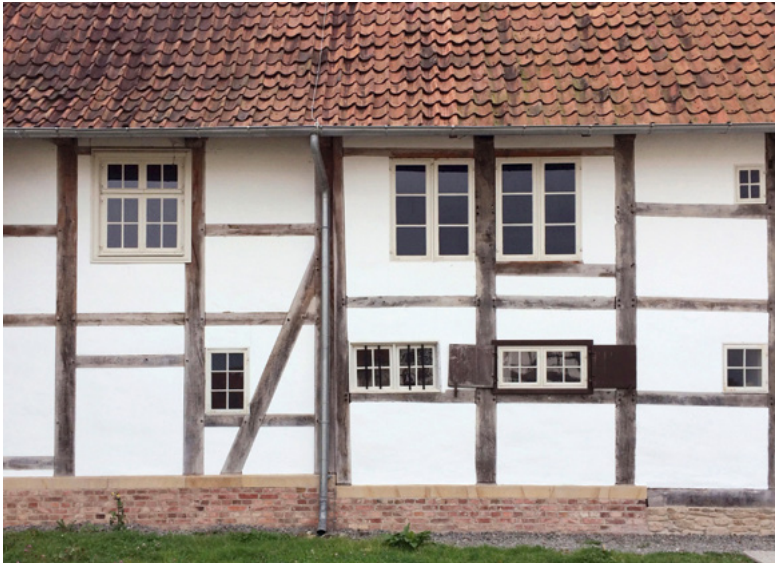
3. Unterschiedliche Anordnung und Größe der Fenster als Spiegel der Baugeschichte. Foto: Dorothee Heinzelmänn, LVR-ADR.
