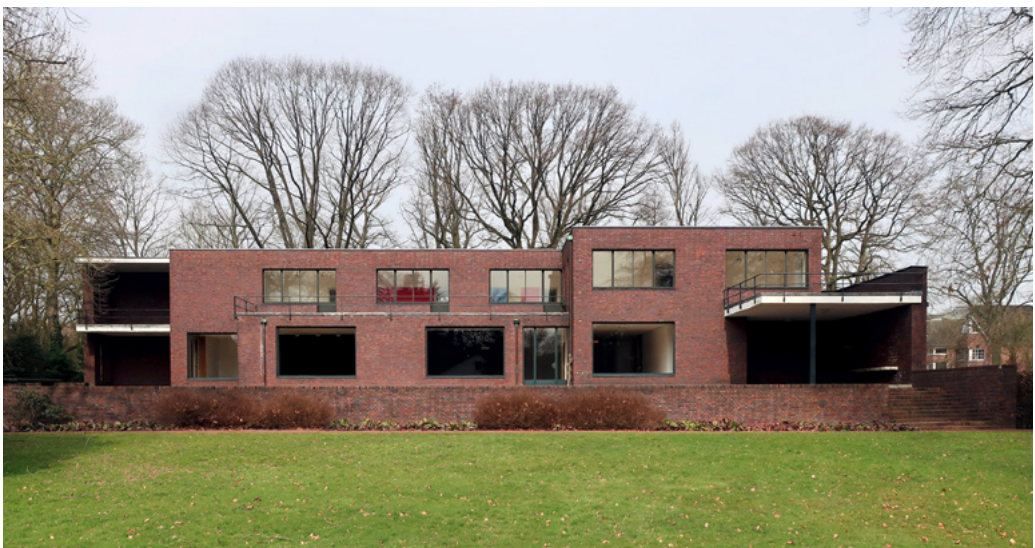
23. Krefeld, Haus Lange, großformatige versenkbare Fenster im Erdgeschoss, Ludwig Mies van der Rohe, 1927–30. Foto: Dorothee Heinzelmann, LVR-ADR.
