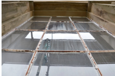
5. Essen-Bredene, Villa Hügel, Belvedere. Schäden an Rahmen und Glas. Foto: Susanne Conrad, LVR-ADR.
