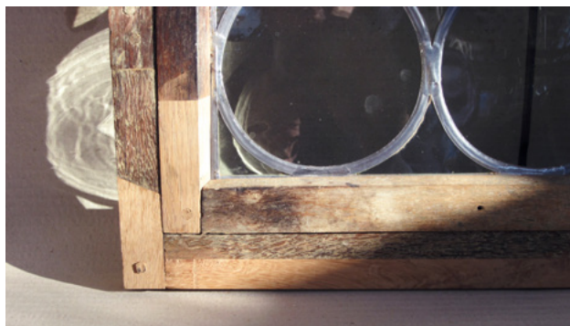
7. Materialgerechte Holzergänzung bei einem Renaissance-Fenster des Hilchenhauses, Lorch, Weltkulturerbe Oberes Mittelrheintal. Foto: Johannes Mosler.
