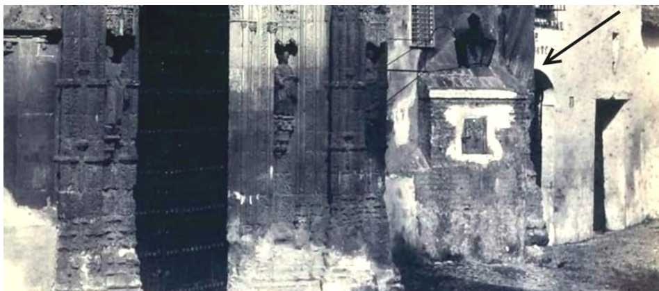
11. Alcubilla en la fachada de la Casa Expósitos (detalle de fotografía de Clifford de 1862)
