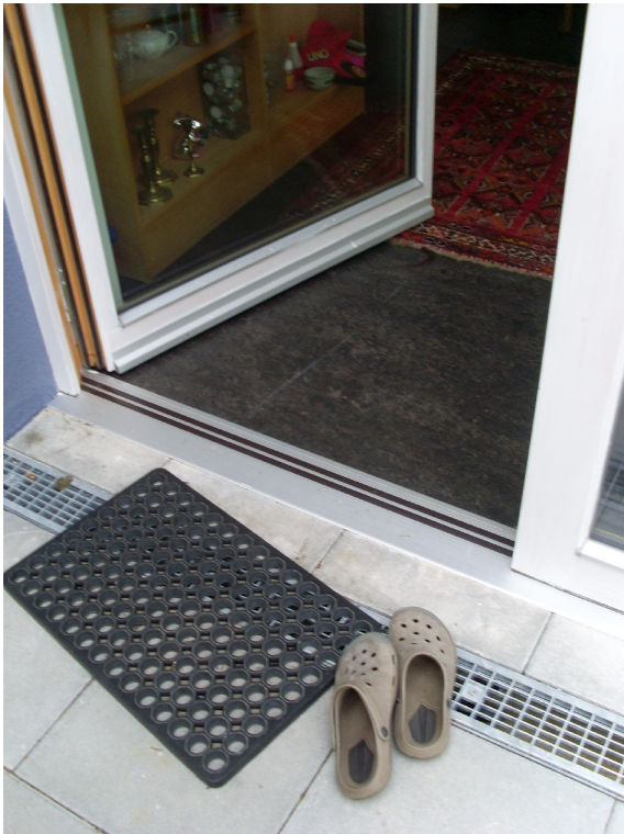
Abbildung 14: Ein schwellenfreier Zugang zur Terrasse
