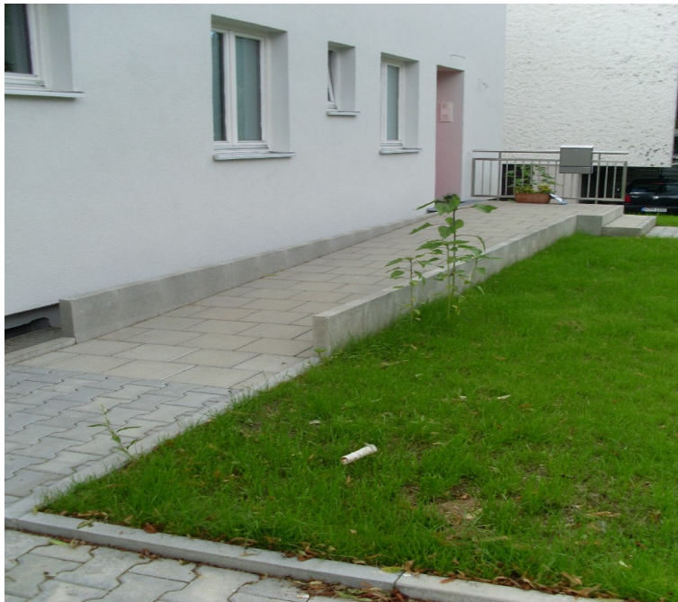
Abbildung 7: Rollstuhlgerechte Rampe mit vergrößertem Eingangspodest
