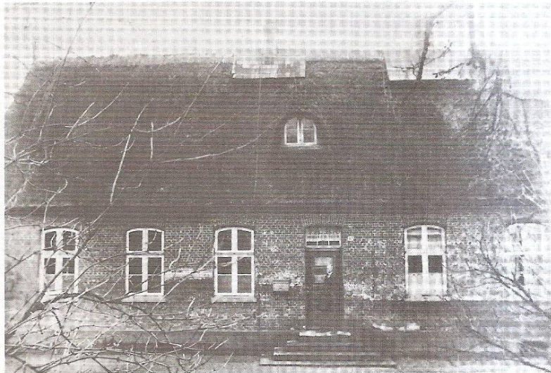
Ehemaliges Schulgebäude in Georgswerder, Niedergeorgswerderdeich 167, gebaut um 1880, ausgebombt.
