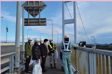
しまなみ海道「小浦高架橋」のロボットカメラによる法定点検作業。(12/2)
