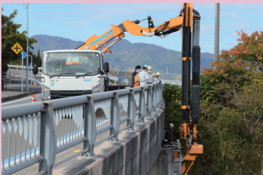
伯方町北浦「新開橋」のゴンドラ車による法定点検作業。(11/2)
