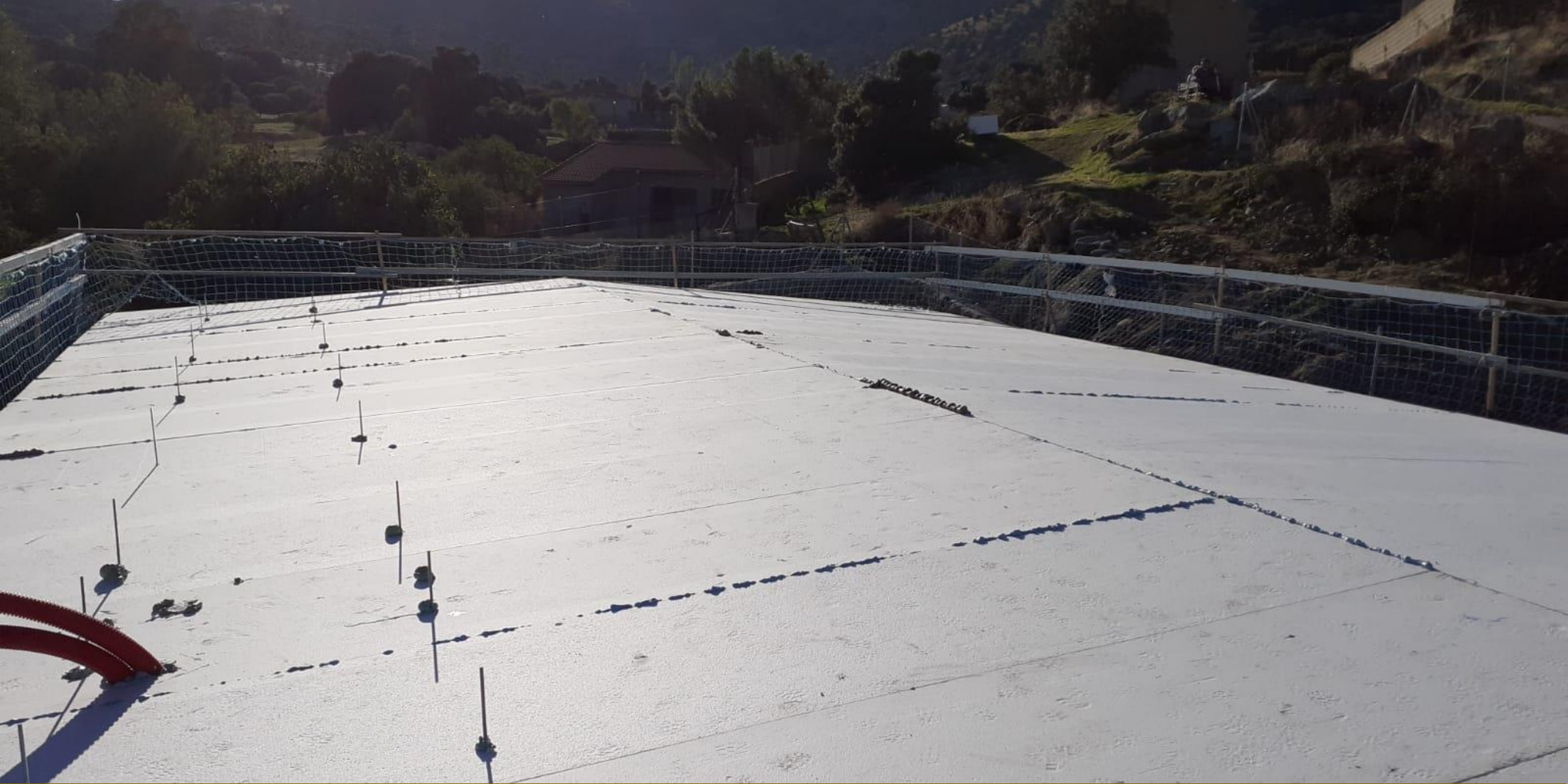
Colocación de placas de Poliestireno EPS, dando formación de pendiente a dos caídas de agua.
