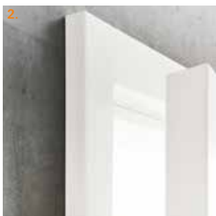
2. stumpfes Türblatt (ohne Türblattfalz) Porte affeurée (sans battue)
