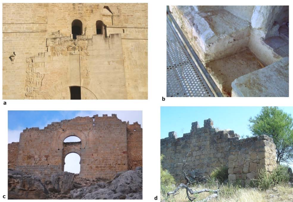
Figura 7.- Detalle de la merlatura que remataba la azotea de la puerta omeya: a.- vista general de los merlones conservados y restituidos; b.- detalle de los merlones, con restos de revestimiento blanco; c.- Puerta principal de la fortaleza de Gormaz; d.- Puerta Sur de la muralla de la ciudad toledana de Vascos.
