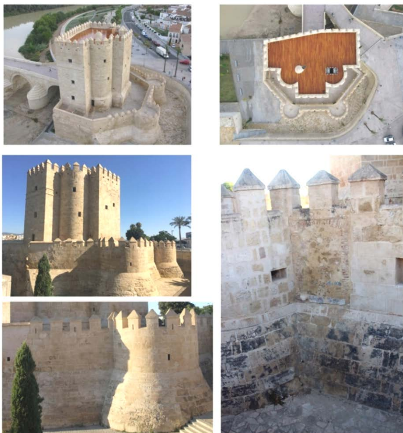
Figura 17.- Vistas generales de la barrera artillera y detalle del portillo con sistema retráctil.
