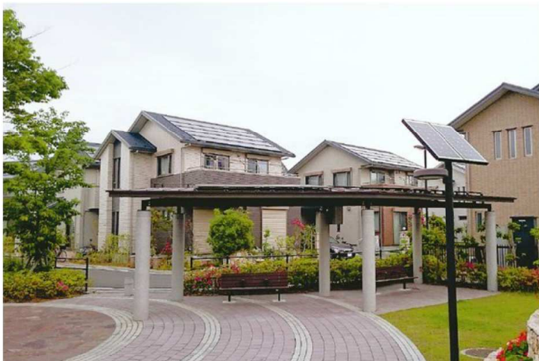
住宅だけでなく公園や街路などエリア内の至るところにソーラーパネルが設置されている
