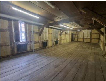
Hofgebäude als Bereich für die zukünftige Dauerausstellung
