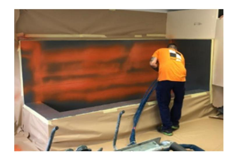
Cubeto totalmente impermeabilizado y estanco para revestir con gresite o pintar con poliuretano.
