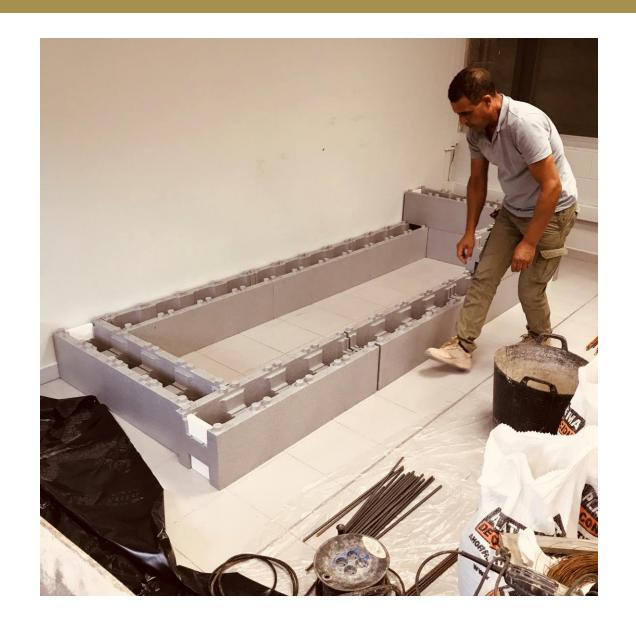
Colocación y anclaje mecánico de barillas dentro de la propia estructura.
