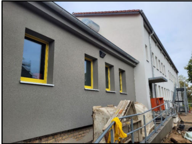
Abbildung 25: Zwischenstand der Fassadensanierung auf der Ostseite.
