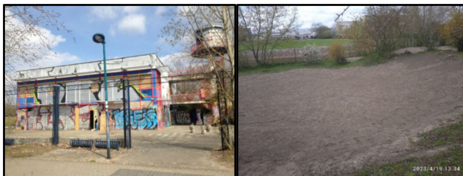
Abbildung 30 und 31: Rückbau des Clubs am Turm im Frühjahr 2023.
