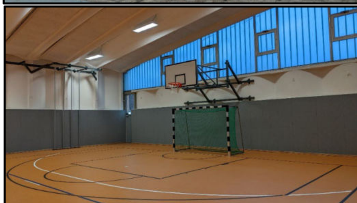
Abbildungen 21, 22 und 23: Nach der abgeschlossenen Sanierung.
