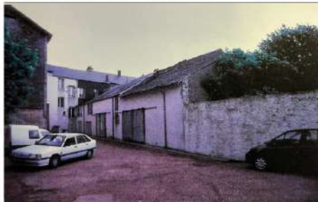
avant les démolitions...
