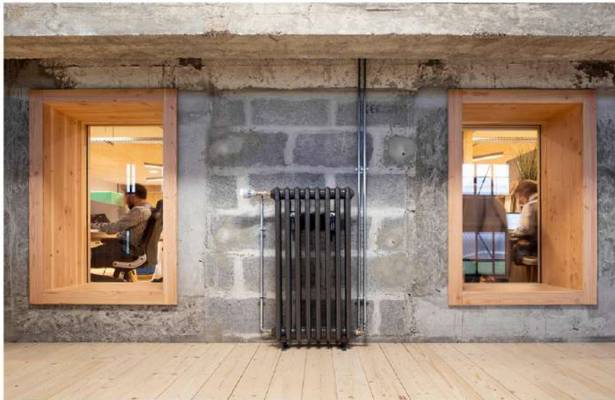
équipements et distribution fluides tout en apparent superposition ancien (brut) / neuf (brut) assumée
