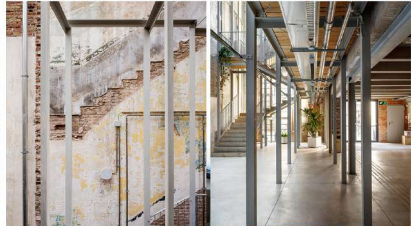
équipements et distribution fluides tout en apparent superposition ancien (brut) / neuf (brut) assumée
