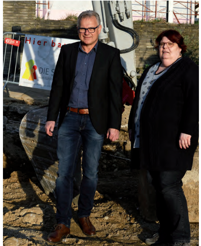
Die beiden SP Bauausschussmitglieder, Bettina Hemm und Manfred Gaßner, bei der besichtigen der Baustelle zur Gehsteigverbreiterung in der Kraftwerkstraße.
