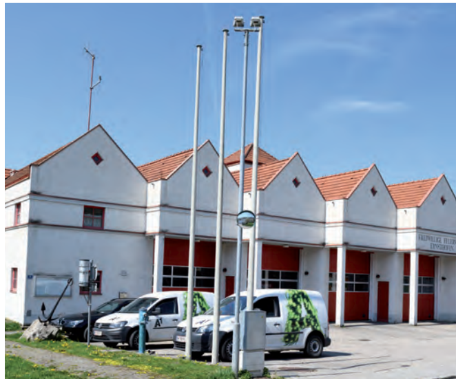
Das Feuerwehrzeughaus mit Bauhof wird, wie auch die Sportanlage, noch mit einem Ölbrenner beheizt.
