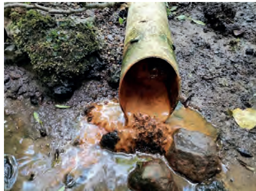
Abb. 5: Vorderer Bereich der Quellflur 4, entwässert und zerfahren, Vegetation mit Dominanz von Stumpf-Ampfer. Rechts: eisenockerhaltiges Quellwasser fließt aus dem Dränrohr und belastet die Bolandsau.
