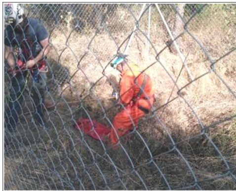
Fig. 6. Descenso al pozo n.º 3
