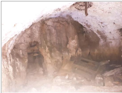
Fig. 9. Cárcavo anexo al acueducto
