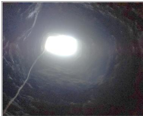
Fig. 7. Encañado del pozo n.º 3
