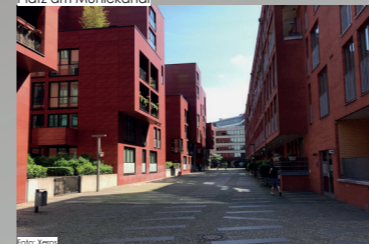
Platz am Mühlekanal
