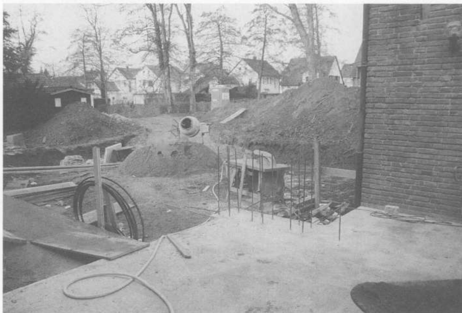
Herbst 2000 - Beginn der Bauarbeiten am Jugendheim
